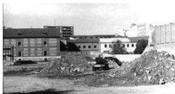
Una excavadora empieza a remover tierra antes de las obras.
