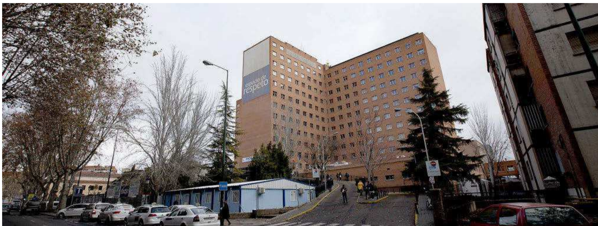
Estado actual del edificio del Hospital Clínico Universitario, en pleno proceso de reforma y ampliación. // J. C. CASTILLO
