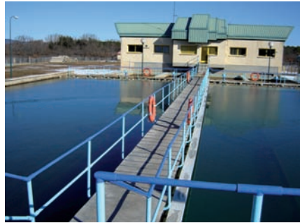
Figura 27 - Decantador de la ETAP de Soria.
