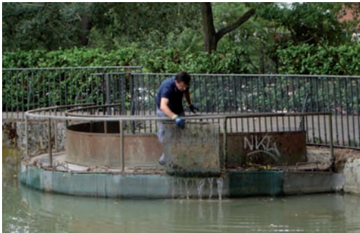
Figura 22 - Desbaste en la ETAP de Valladolid.
