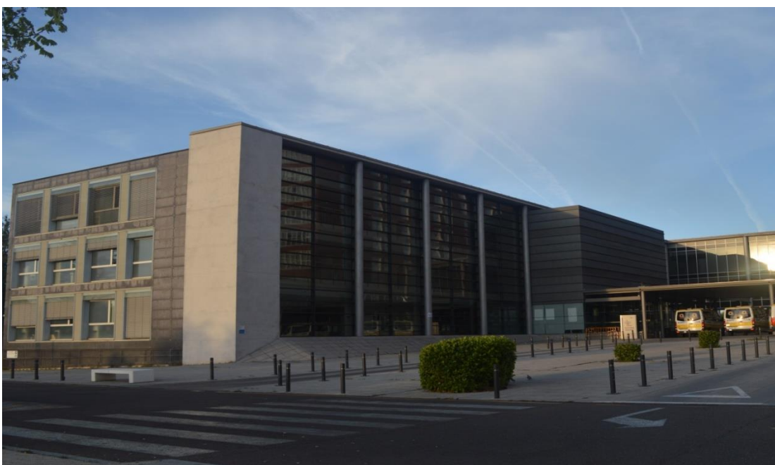
Edificio de Consultas Externas
