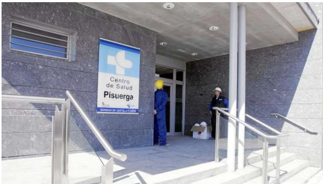
Centro de salud de Arroyo de la Encomienda
