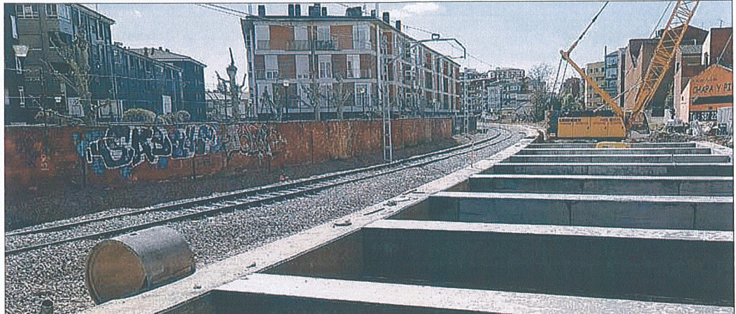
Losa ferroviaria de nueva construcción por donde avanzará el tren de León hacia Asturias. RAMIRO
