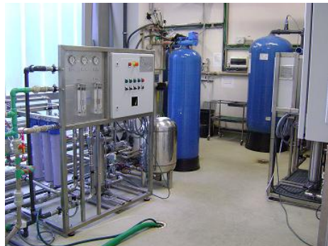
Planta producción de agua en la unidad de hemodiálisis
