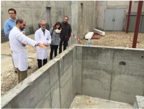
Balsa recogida rechazo paneles evaporativos en construcción (izda) y finalizada (derecha)
