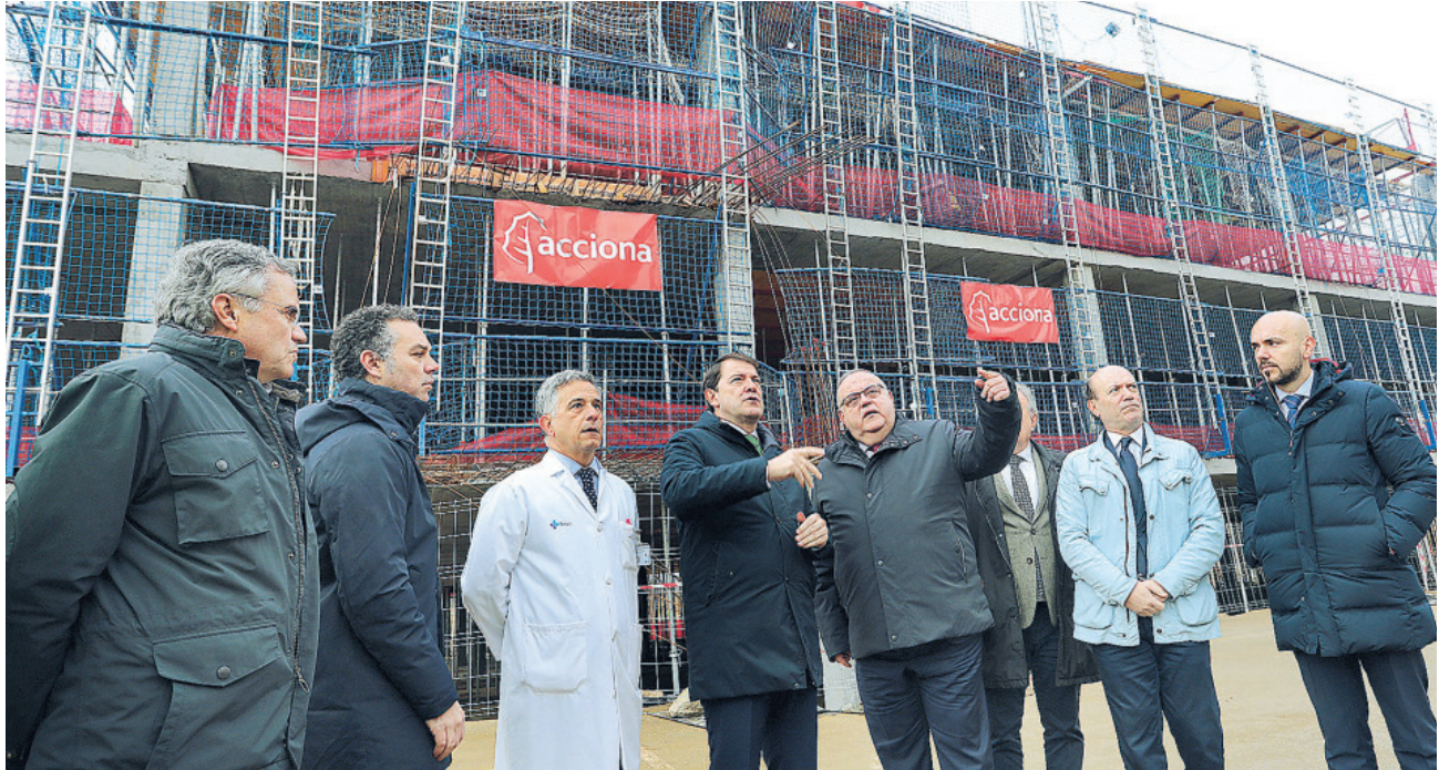
Fernández Mañueco y el consejero Alejandro Vázquez durante una reciente visita a las obras en el Hospital de Palencia
