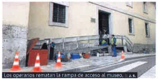
Los operarios rematan la rampa de acceso al museo. :: J. S.
