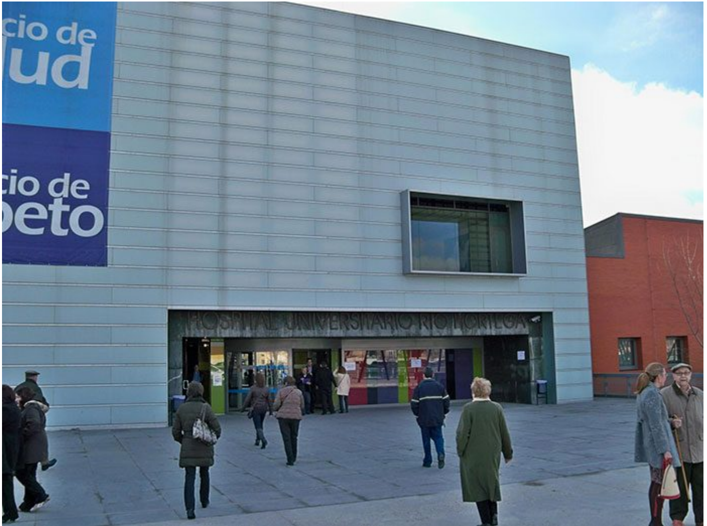
Fachada del Hospital Río Hortega de Valladolid./ Europa Press
