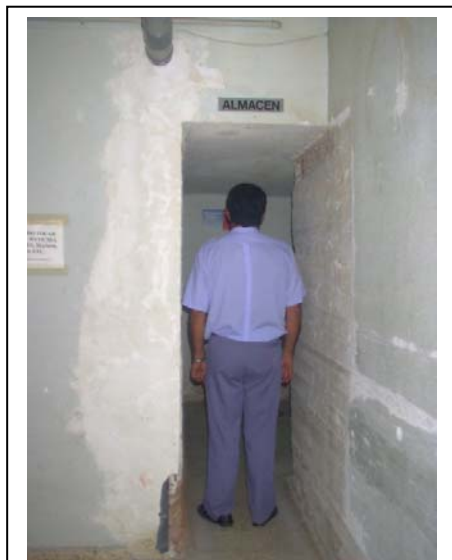
Acceso a Almacén General
