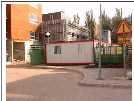
Acceso a Biblioteca
