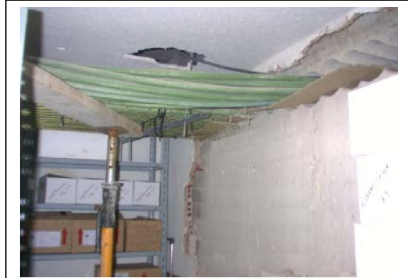
Almacén de Farmacia Detalle techo
