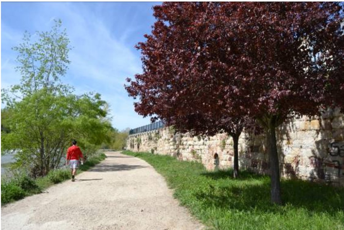
Figura 2. Tercer Recinto Amurallado. Siglo XIV. Puerta de Toro.
