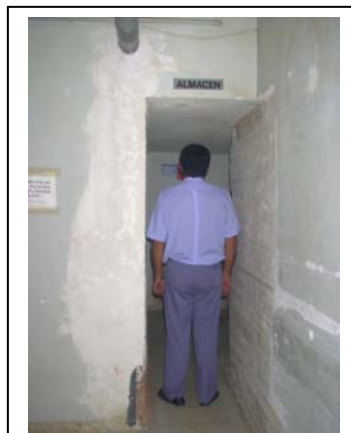
Detalle de acceso a almacén General
