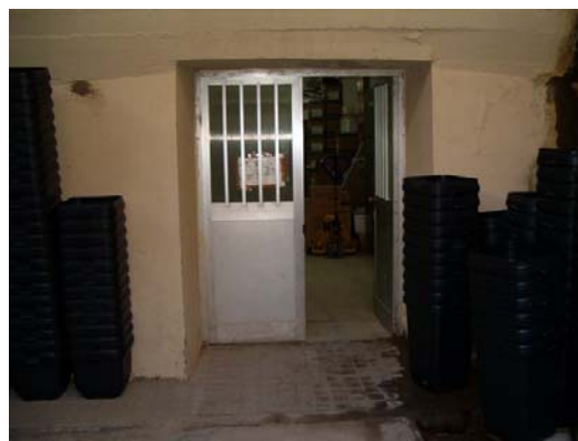
Acceso a Almacén
