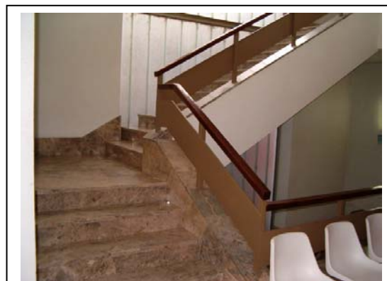
Escalera edificio Materno Infantil (S5M)
