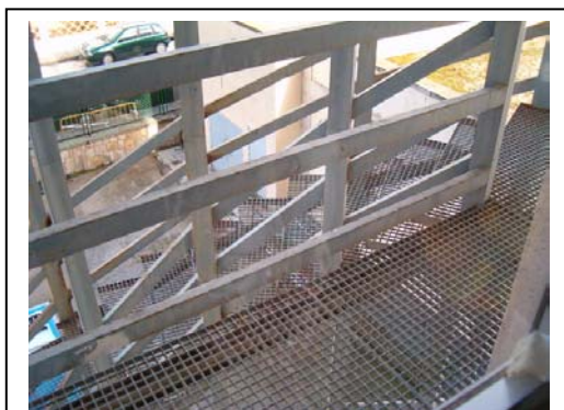
Escalera exterior (B5E)
