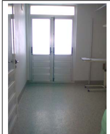
Puerta de emergencia en Unidad de Cuidados Intensivos
