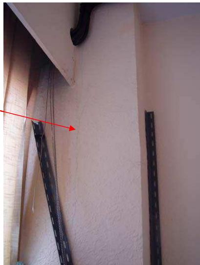
Al realizar la correspondiente roza con objeto de analizar el alcance de dicha fisura se observó que los pilares (dimensiones 30x40 cm tal y como se indicará más adelante) han sido aumentados de dimensión en la dirección perpendicular a la fachada y hacia el interior del edificio con ladrillo, coincidiendo dichas fisuras con la separación entre hormigón del pilar y el ladrillo añadido, no siendo por tanto un desperfecto estructural.
