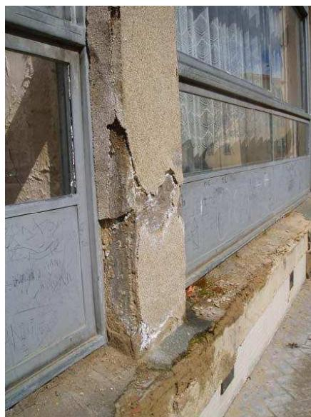
Sin embargo, esta mayor degradación afecta fundamentalmente al recubrimiento exterior no estructural de vigas y pilares, siendo más acusada en las vigas y pilares de cubierta de todo el edificio.
