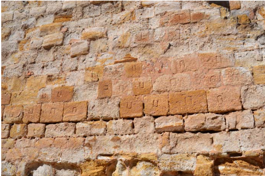
Figura 9. Segundo Recinto Amurallado. Siglos XII-XIII. Ronda de Santa Ana. Marcas de Cantero (detalle).
